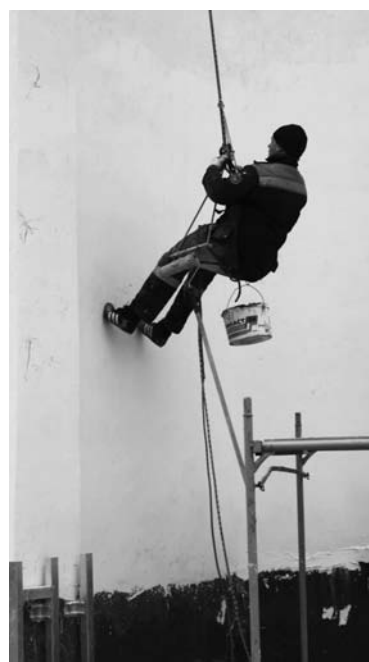
За 30-летнюю историю ДК это его первый капитальный ремонт.
