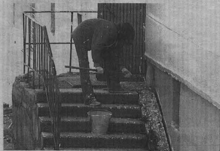
Комитет контролирует все ремонтные работы на объектах города.
