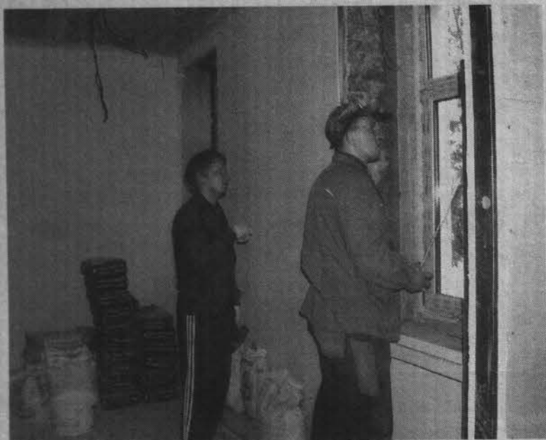
Пока в кабинете врача общей практики работают строители «МСК».
