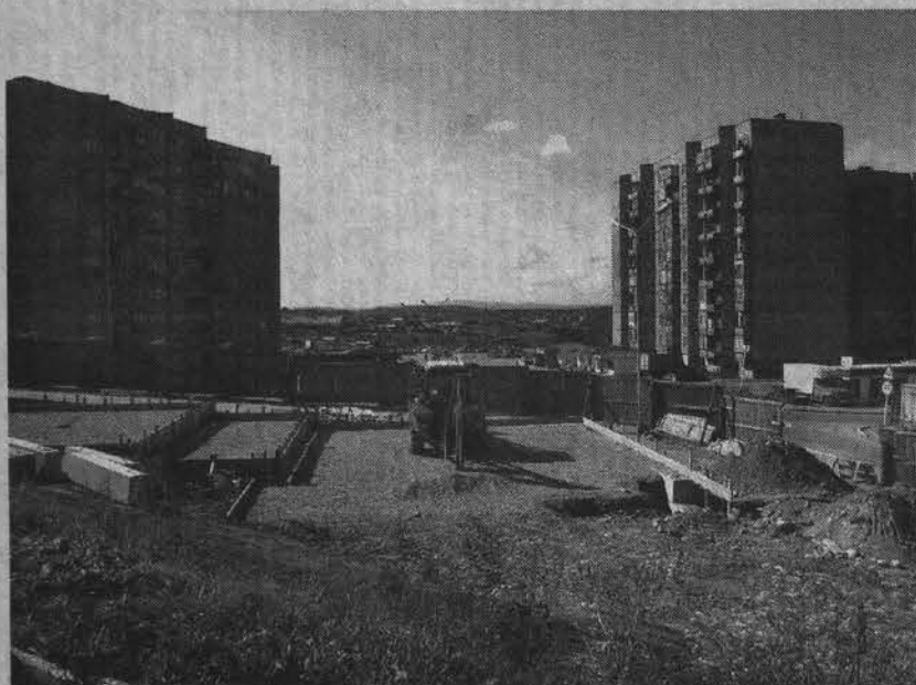
Основанием нового магазина будет бетонная плита.
