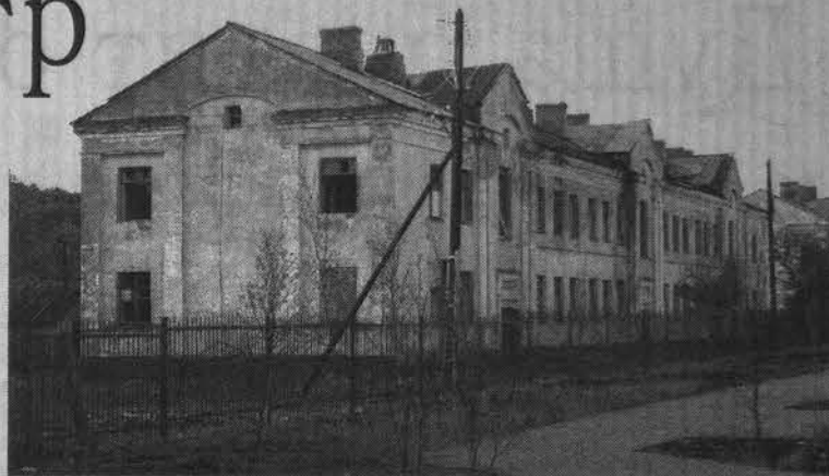
Здание будущего детского центра требует значительного вложения средств.
