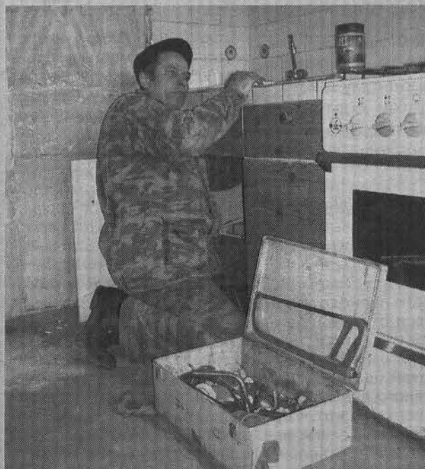
Сантехник ЖЭУ-1 Иван Царенко проводит работу по прочистке труб ГВС и ХВС. А такая услуга в ООО «СЖКХ» теперь стоит 134 рубля за 1 метр.
