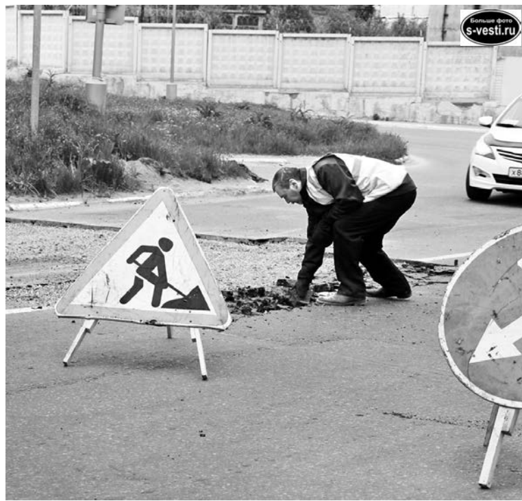
Ямочный ремонт на ул.Ломоносова.
