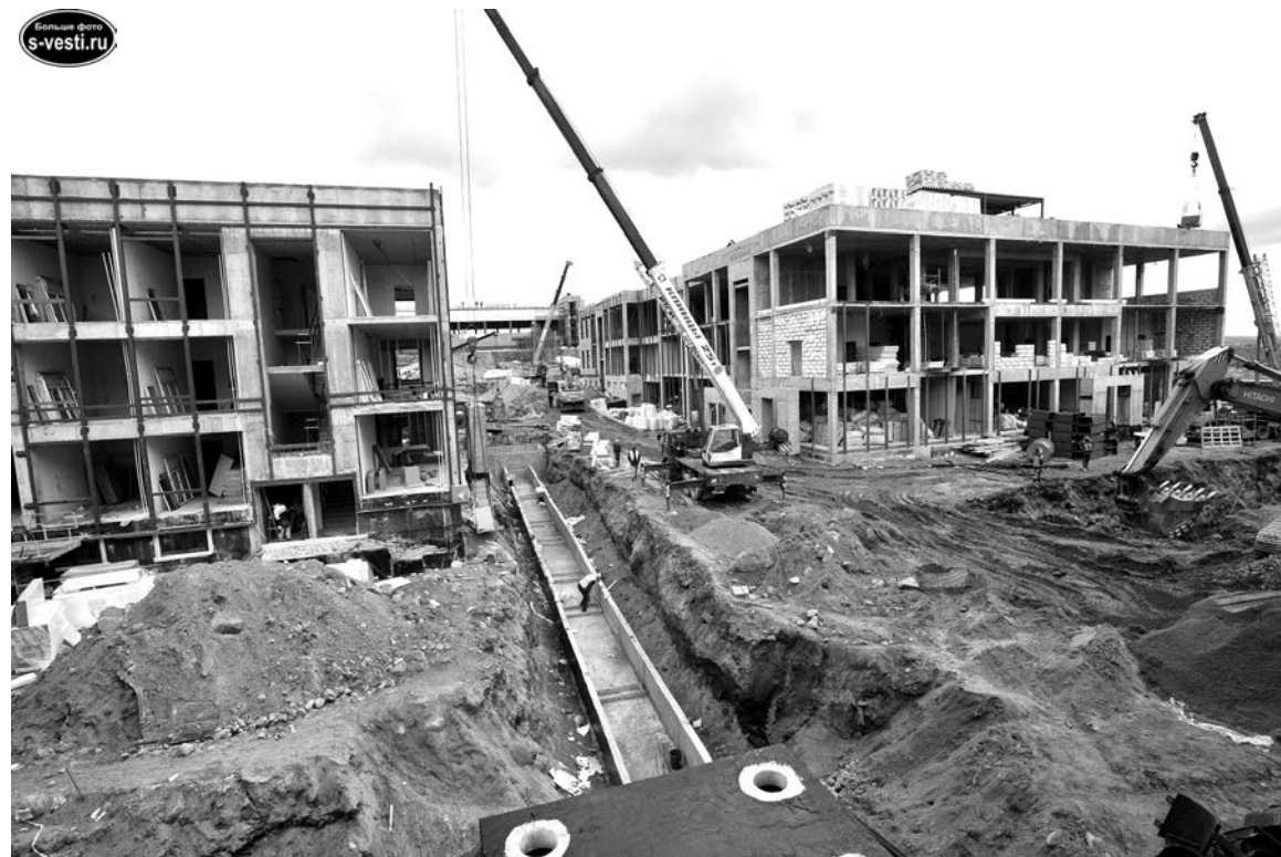
На стройплощадке проложено 658 м теплотрассы и 800 м водовода.
