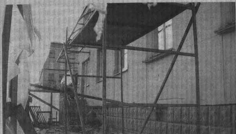
Обустройство магазина на ул.Душенова, 16, владелец позаботится о внешнем облике остановки.
