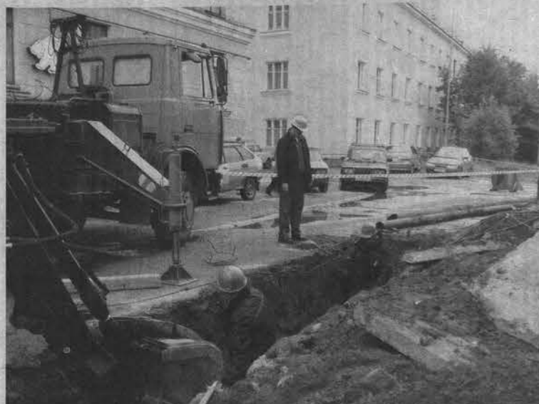
Работы по замене теплотрасс и ГВС на ул. Комсомольской завершаются.
