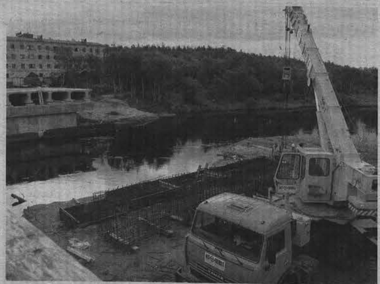
Возведение второй опоры моста потревожило речную жизнь. Экологи надеются, что ненадолго.
