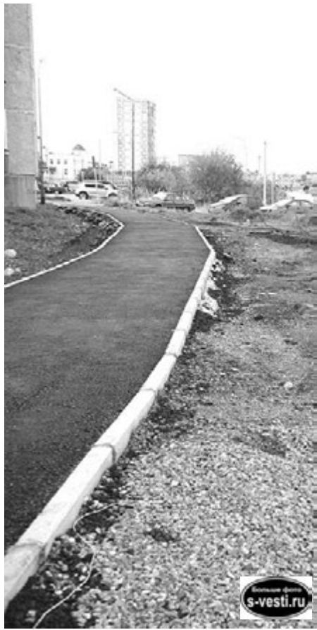
Заасфальтированная дорожка вдоль дома №33 по ул.Падорина.
