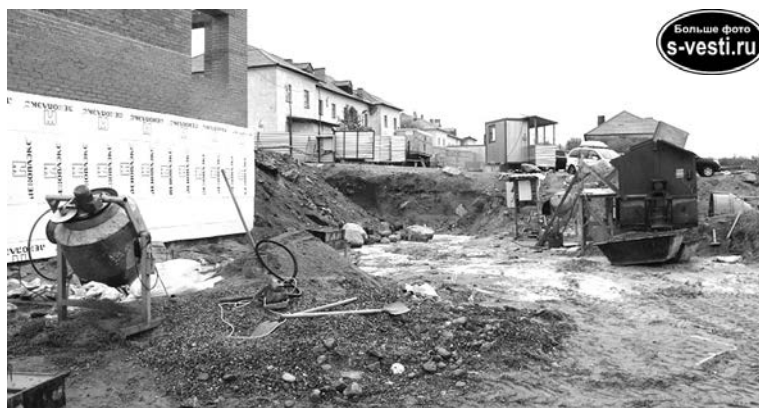
Вопреки графику, работа на строительной площадке не кипит...
