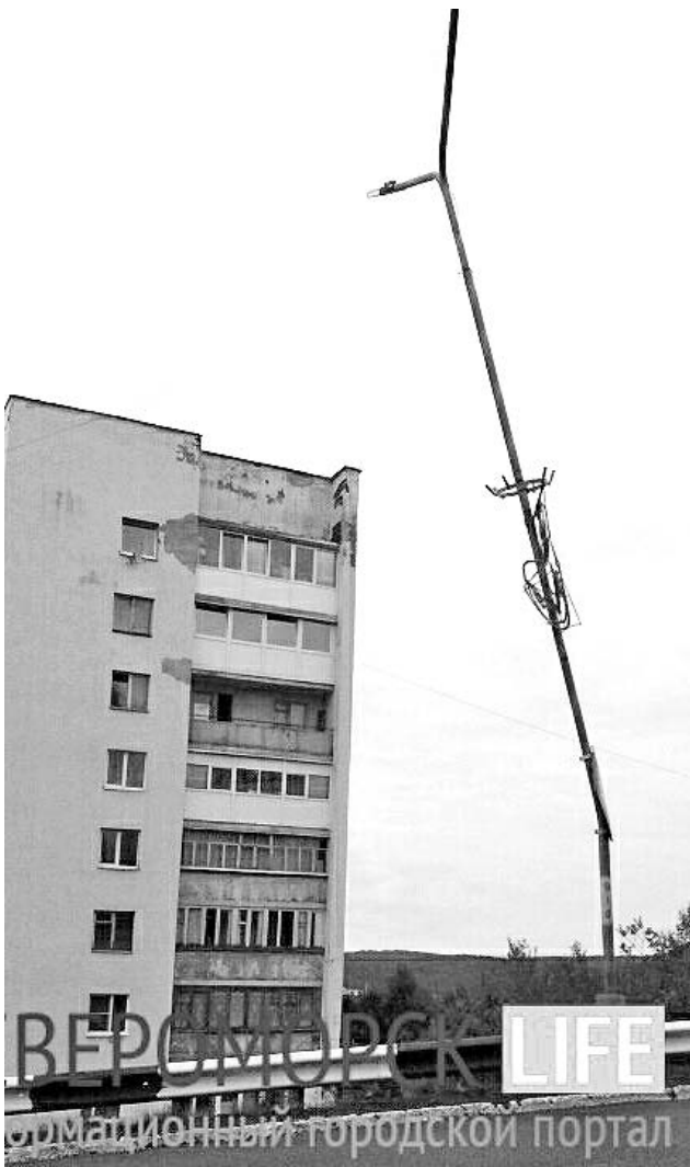
На спуске по улице Душенова опасно накренился фонарь и провисли провода.
