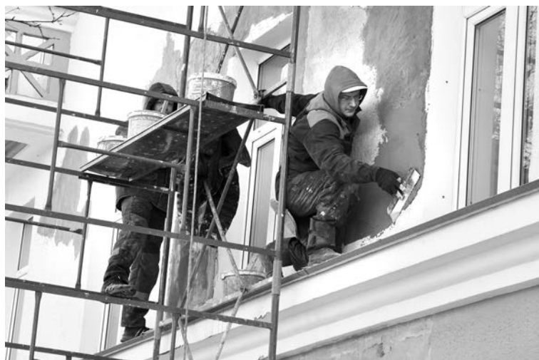
Дома Северноморска ремонтируют по плану.
