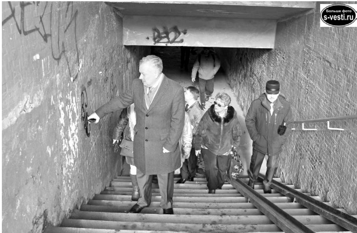
Участники рейда убедились в необходимости установки поручней в подземном пешеходном переходе на перекрестке улиц Кирова-Душенова.
