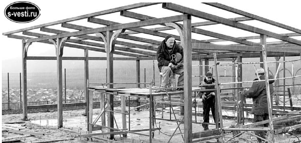
Необходимое для благоустройства дворовой территории оборудование закуплено в полном объеме.
