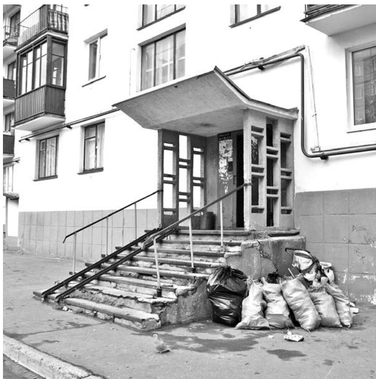
Мусор из захламленной квартиры выносили мешками и вывозили грузовиком.
