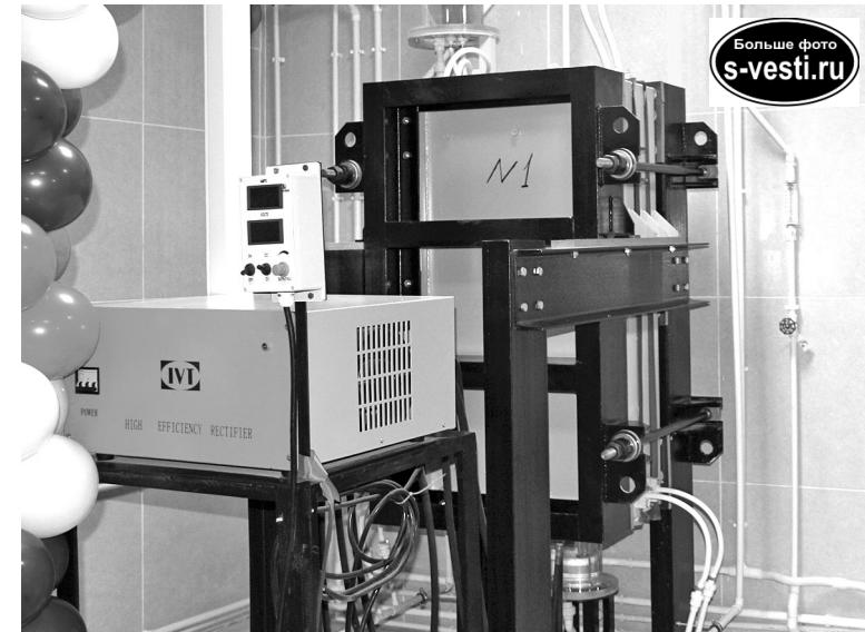
**Мембранны-электролизная система обеззараживания воды успешно выполняет свою функцию.**
