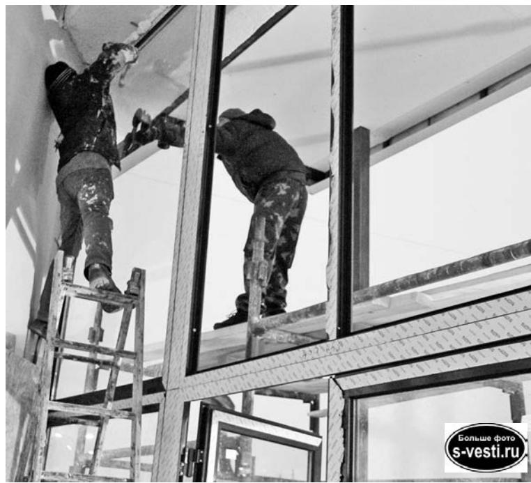
Ремонтные работы кипят почти без перерыва.
