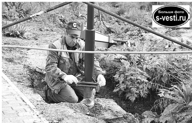
Фонарные опоры уже стоят - идет монтаж светильников.
