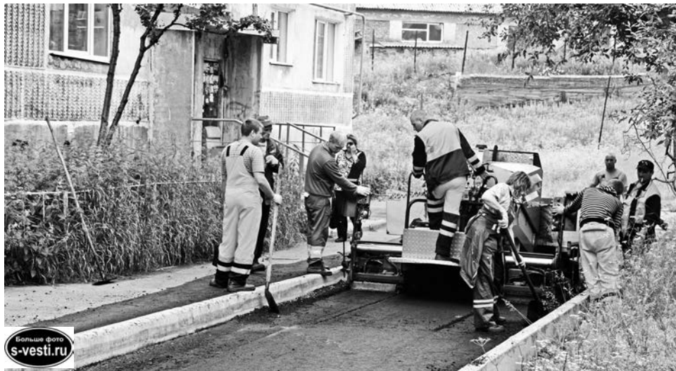
На ул. Колышкина, 10 уже лежит новый асфальт.
