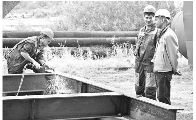
На котельной 7-го района в п. Росляково идет монтаж нового котла.
