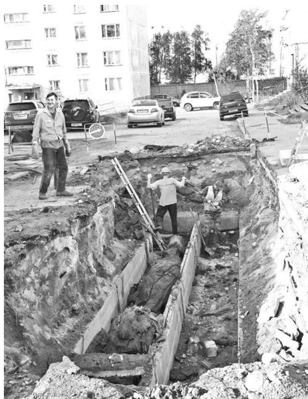
Новые пенополиуретановые трубы, которые «Североморские теплосети» укладывают на ул.Падорина, 10, должны прослужить минимум 25 лет.
