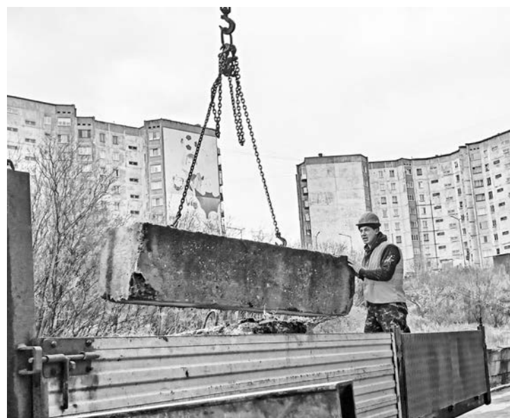
Безопасность превыше всего: накренившиеся бетонные блоки, представлявшие угрозу, демонтированы.
