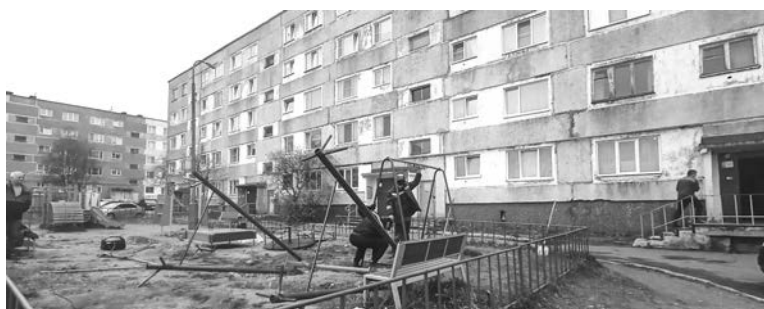
Монтаж игровых элементов на детской площадке на ул. Кирова, 3.
