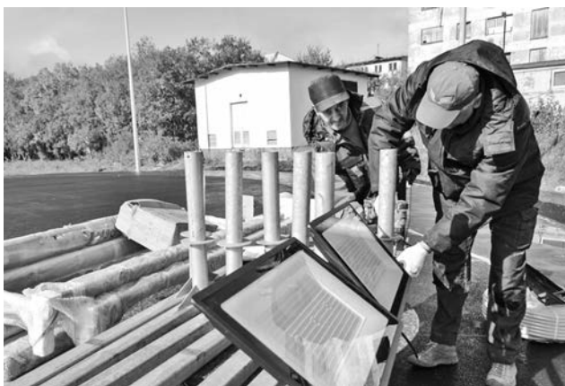
Монтаж 4-рожковых светильников на новом стадионе.
