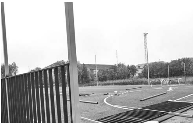
Строящийся корт в Североморске-3 вскоре порадует спортсменов гарнизона.
