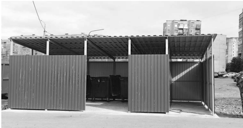
Строительный мусор после модернизации контейнерной площадки убран (ул. Вице-адмирала Чабаненко, 5).
