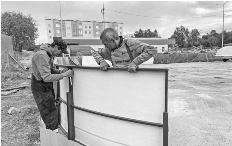
В Сафоново-1 продолжается обновление корта. Борта уже установлены, в ближайших планах — асфальтирование основания.
