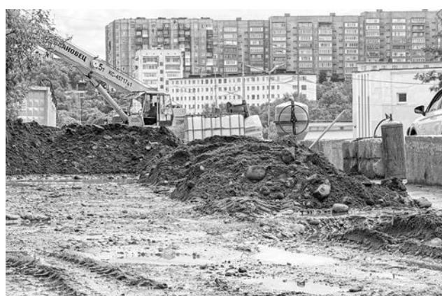
В режиме реновации: замена теплосетей под контролем тяжелой техники.
