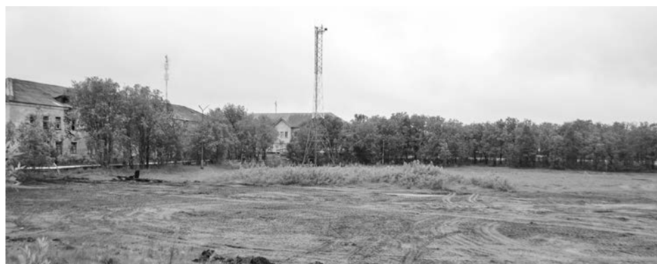
Подготовка основания под будущую спортивную площадку, строительство которой ведется в рамках губернаторской программы «На Севере — твой проект».
