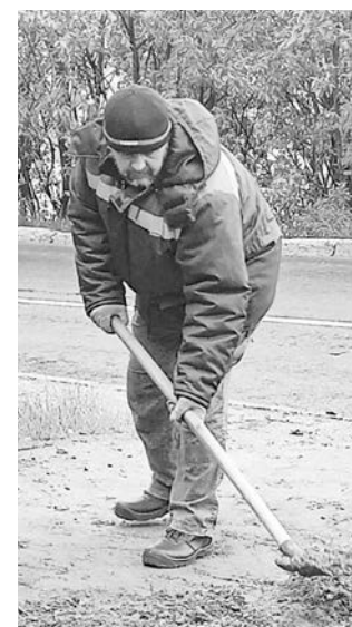
Продолжаются работы по асфальтированию.
