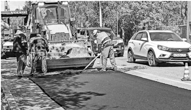
Долгожданный ремонт дороги на въезде в Авиагородок.
