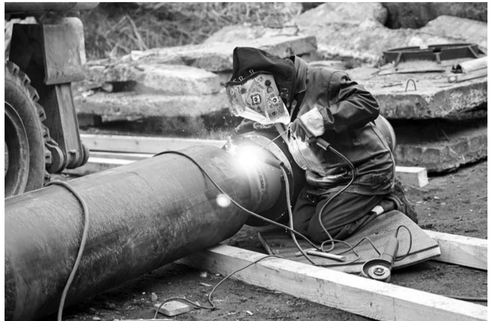
Сотни сварных швов предстоит сделать сварщикам на участках новых трубопроводов.
