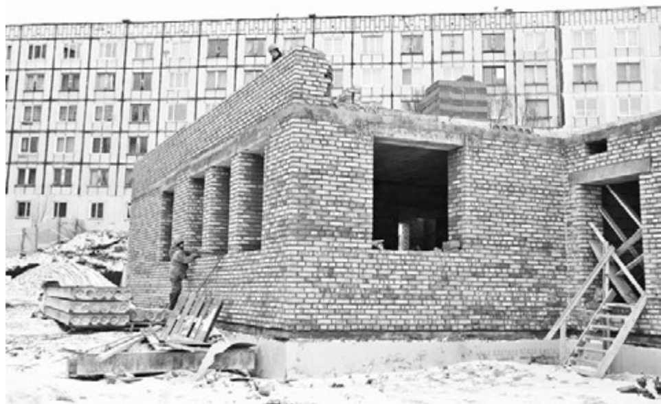
Строительство детского сада на 140 мест в районе улицы Флотских Строителей идет с опережением плана.
