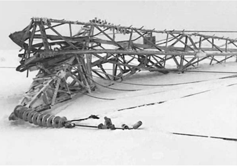
Одна из пяти упавших опор ЛЭП, которые стали причиной аварии.
