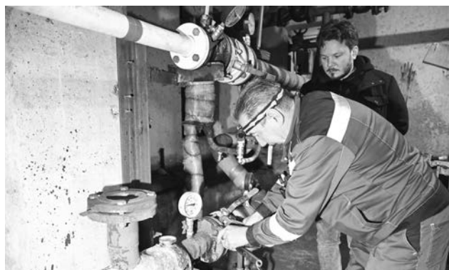
Аварийная бригада устраняет аварию на внутридомовых сетях МКД.
