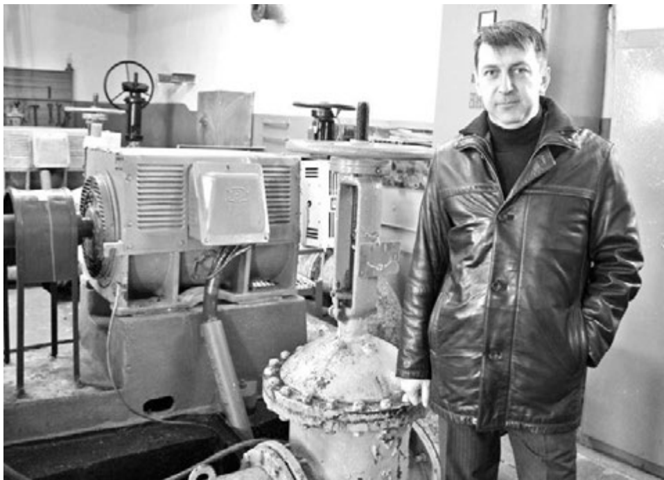
Александр Каменев: «Оборудование насосных станций не новое, но его не стыдно показать. К примеру, специальное покрытие, применяемое в космонавтике, заменяет теплоизоляцию».
