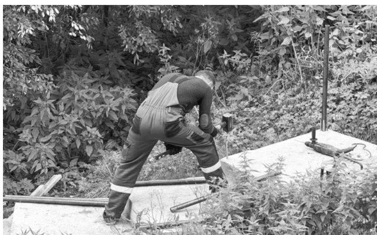
На ул. Сгибнева, 11, в активной фазе восстановление трапа.
