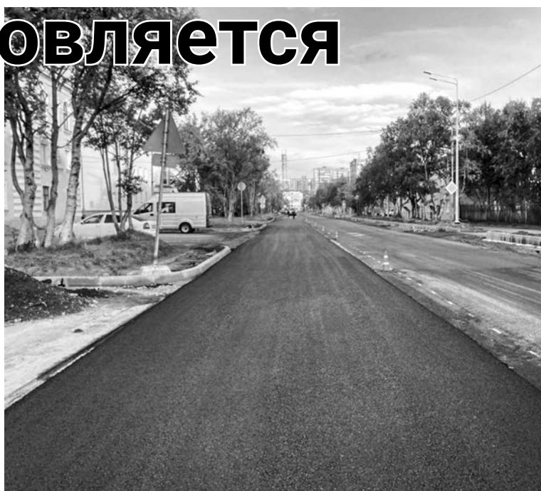
На проезжей части снят старый асфальт, идет укладка нового.
