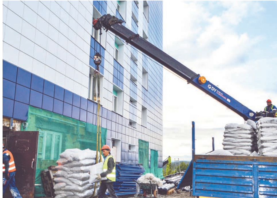
Подвоз и разгрузка стройматериалов для ЦРБ ведется непрерывно.
