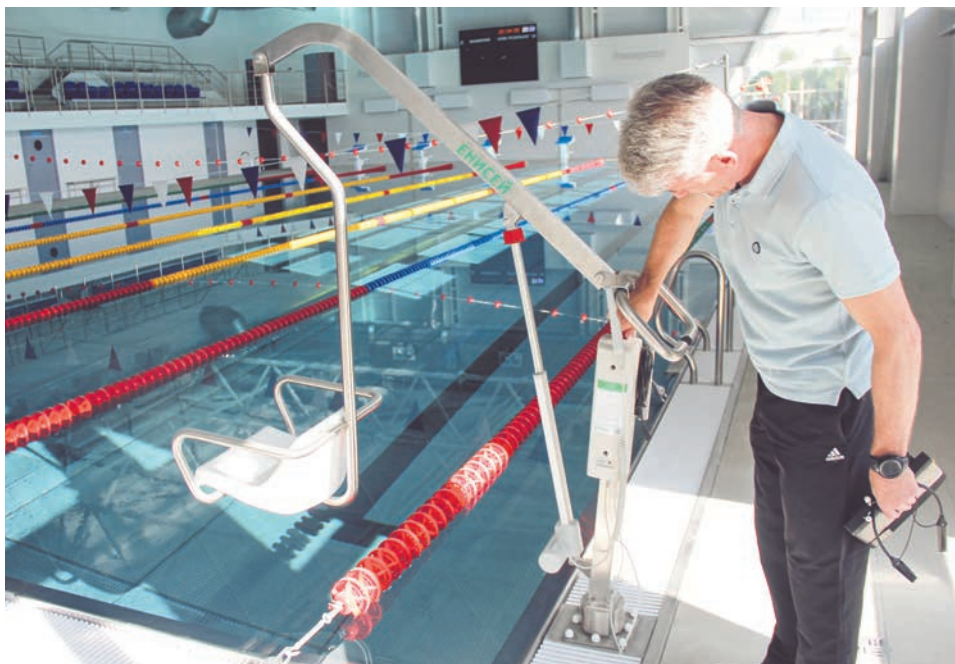
Индивидуальное устройство для спуска в воду и подъема маломобильных граждан.
