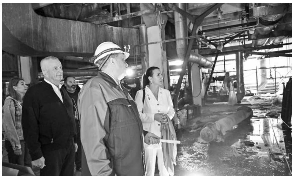
О ходе работ по подготовке к отопительному сезону Евгению Алексееву и Светлане Ефремовой подробно рассказал Сергей Варламов.
