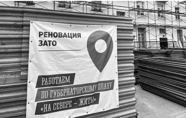
В настоящее время преобразуются фасады домов вдоль всей улицы Сафонова.
