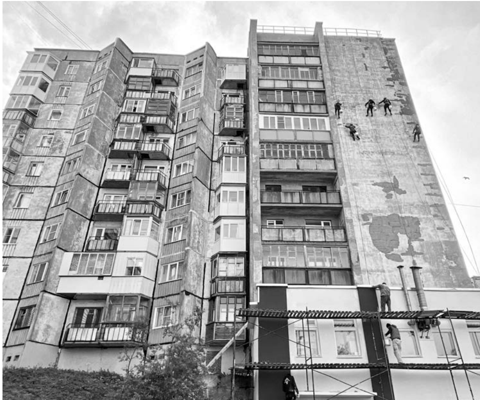
Работы на улице Гвардейская, 34а.
