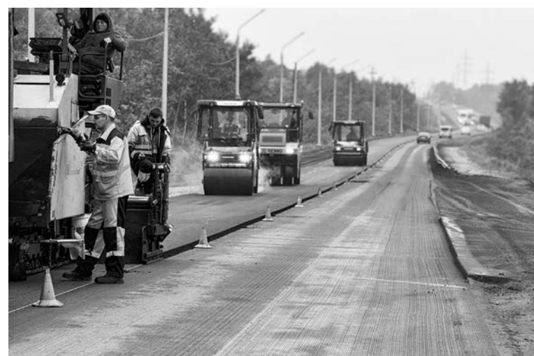
Ремонт объездной дороги в Североморске.
