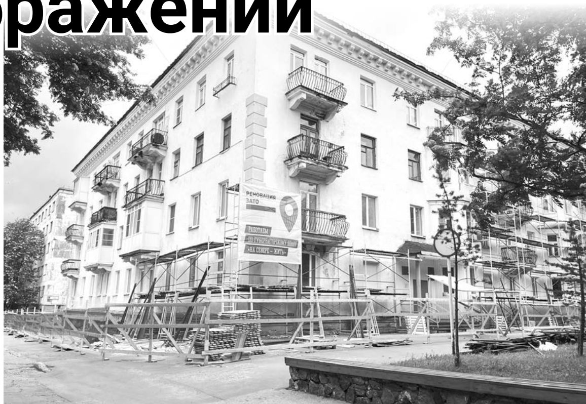
На улице Сафонова сейчас продолжается ремонт фасадов домов по программе реновации ЗАТО.
