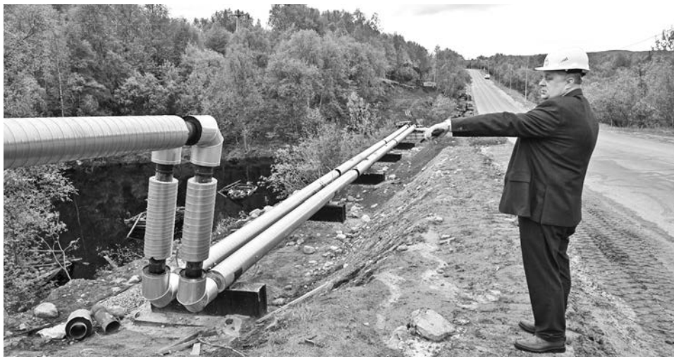
Сергей Варламов рассказал, что всего здесь будет отремонтировано порядка шести километров теплотрассы.
