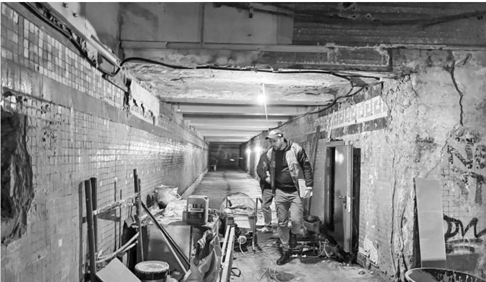
Отделочные работы согласно контракту должны быть завершены в конце июня.
