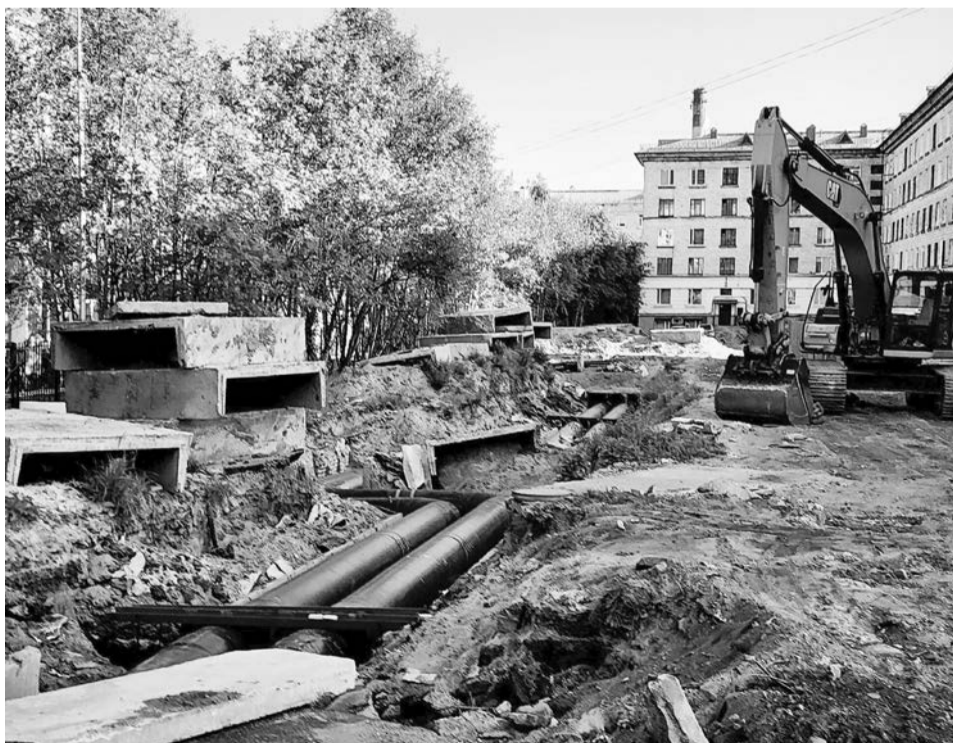
На финишной прямой замены магистрального трубопровода, снабжающего теплом верхние микрорайоны Североморска. Большую часть сварочных работ на этом участке выполнил электрогазосварщик 6 разряда Алексей Ганзя.
