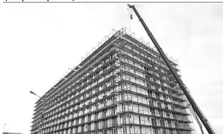
В Североморской ЦРБ сейчас идет ремонт входных групп, кровли, а также замена оконных блоков.
