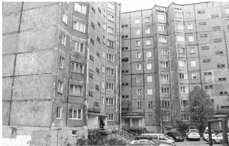
Жильцы девятиэтажки на улице Корабельной, 2 возлагают на новую управляющую компанию большие надежды.
