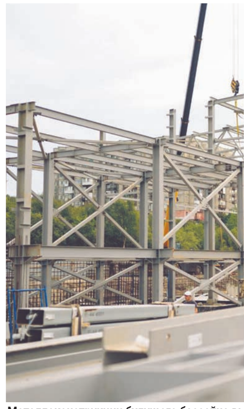
Металлоконструкции будущего бассейна выглядят внушительно.
