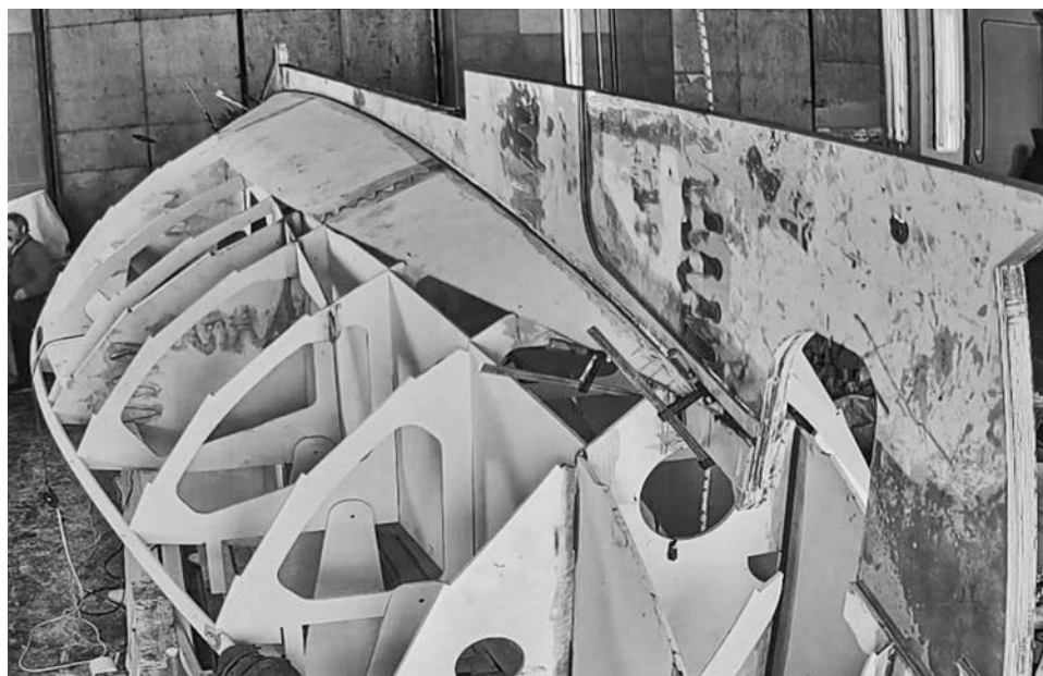
«Шаста» в процессе строительства.
