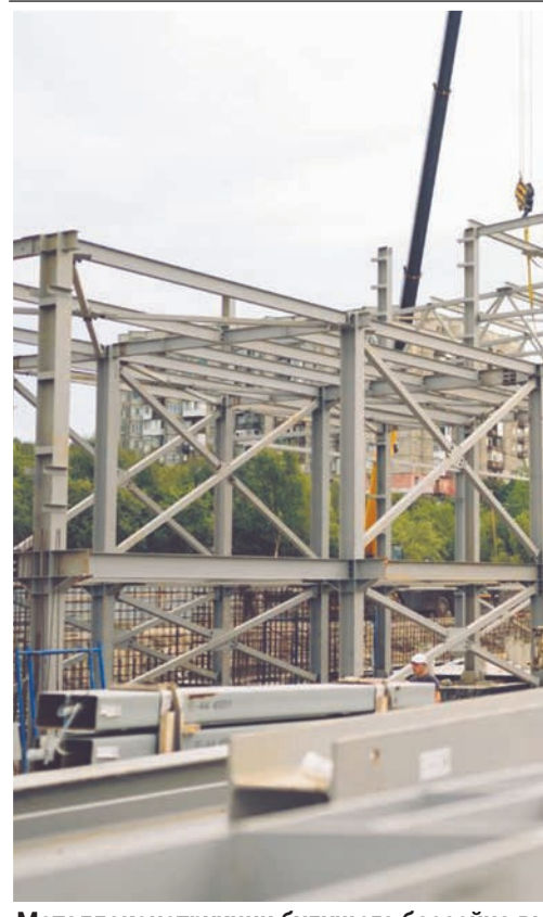
Металлоконструкции будущего бассейна выглядят внушительно.
