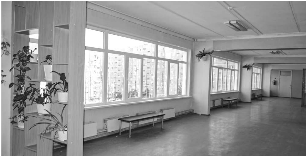
Масштабная работа по замене 160 окон в гимназии №1 в рамках проекта «Арктическая школа» подходит к завершению.
