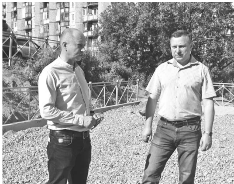
Директор ГЦ ЖКХ Константин Ухарев доложил главе ЗАТО Олегу Прасову о ходе работ на ул. Корабельной.
