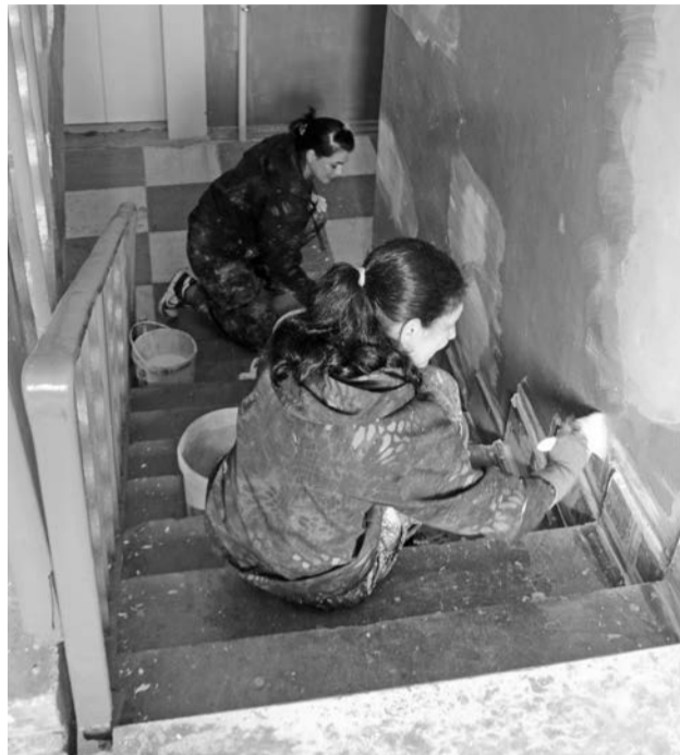
Специалисты «Службы текущего ремонта» штукатурят стены.
