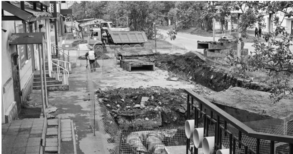
На Советской подрядчик скоро должен начать сварочно-монтажные работы.
