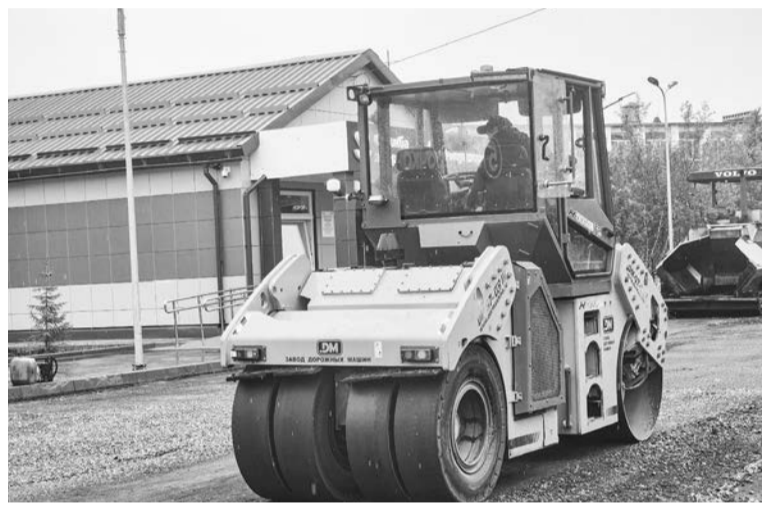
Благоустройство территории рядом с амбулаторией в Североморске-3.
